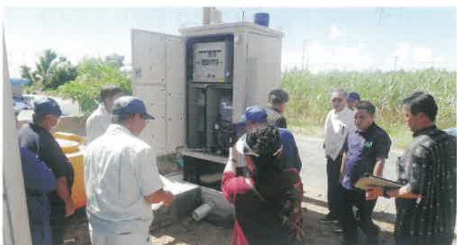
宜野座地区農業集落排水中継ポンプ更新工事(その1)
